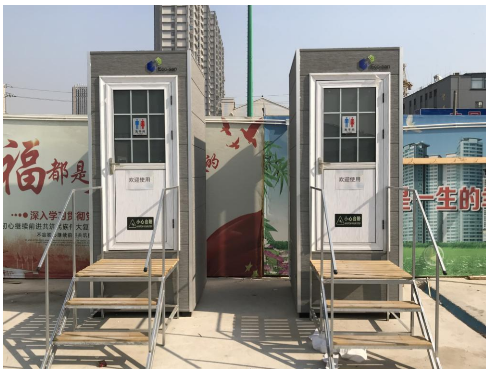
图2 生活污水简易收集设施
